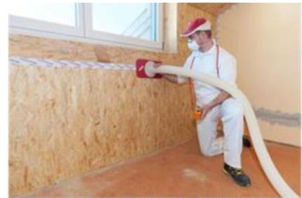
Beim Dachausbau wird Zellulose in Hohlräume eingeblasen
