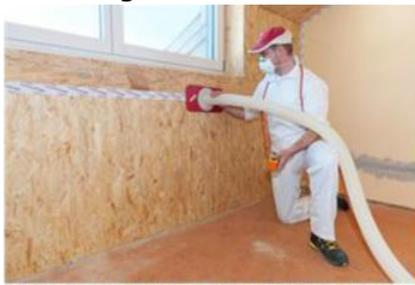
Beim Dachausbau wird Zellulose in Hohlräume eingeblasen
